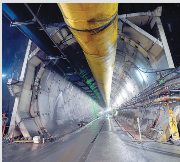
Il cantiere della Tav Torino-Lione
